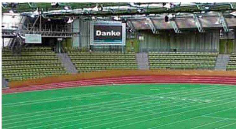
Glaspalast te Sindelfingen, indoor atletiek Arena.
